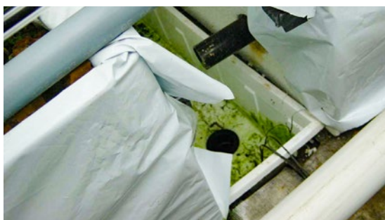
Drainage van een teeltbed
