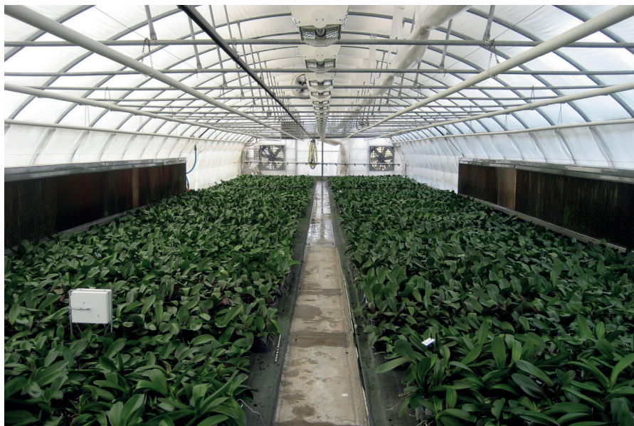
chłodzenie metodą pad & fan w niskiej szklarni
