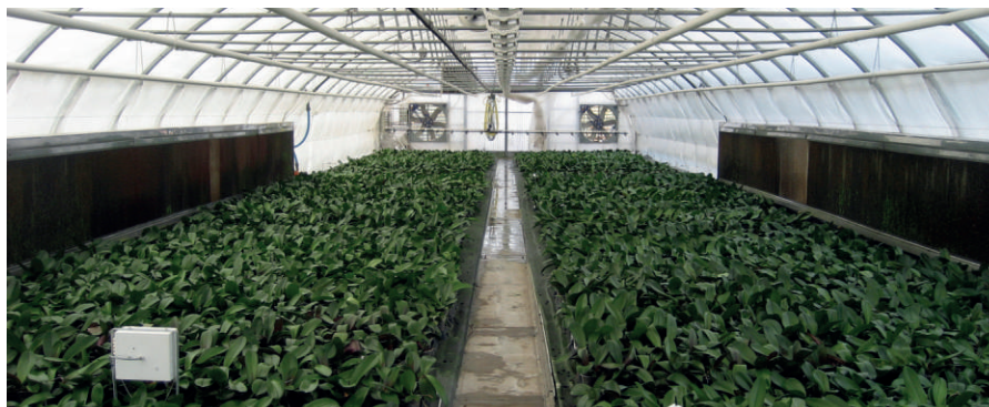
Pad en fan koeling in een lage kas
